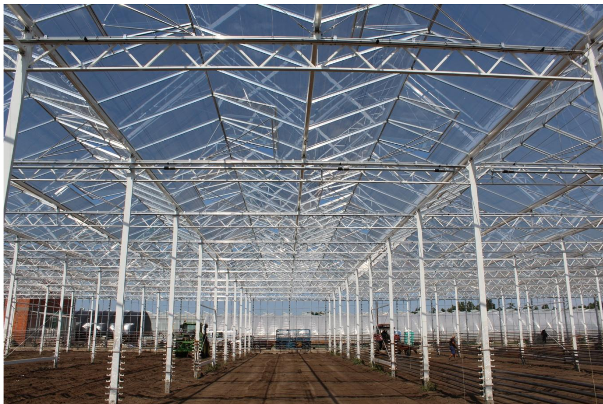
(új szegvári üvegház, építés közben; fotó: 2020.08.13.)
