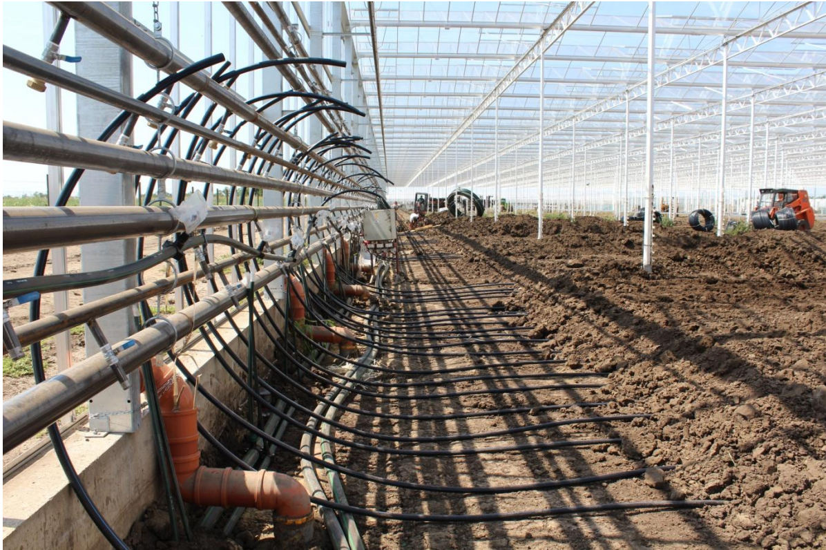
(új szegvári üvegház, vezetékek elhelyezése; fotó: 2020.08.13.)
