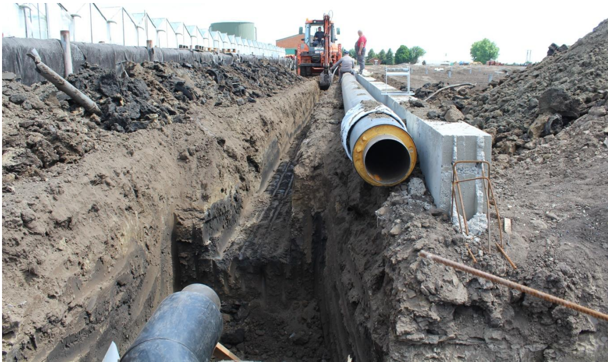
(szigetelt termálvezeték elhelyezése az új szegvári üvegháznál; fotó: 2020.május 25.)
